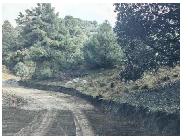
道路工程区排水沟
