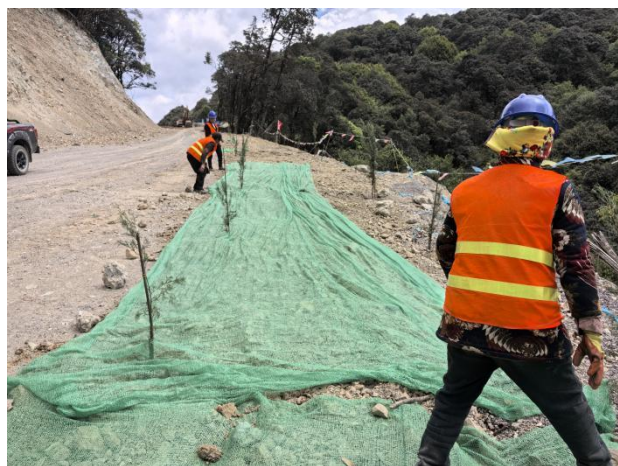
道路工程区绿化植草恢复
