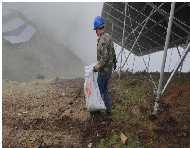
集电线路工程区撒播草籽照片
