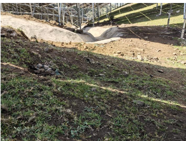
施工场地区植草恢复照片
